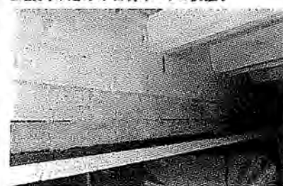
図耐火のための石膏ボード2枚張り
