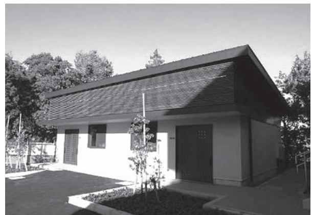
写真1 木造庁舎の整備事例 (平塚地方合同庁舎 会議室棟)
