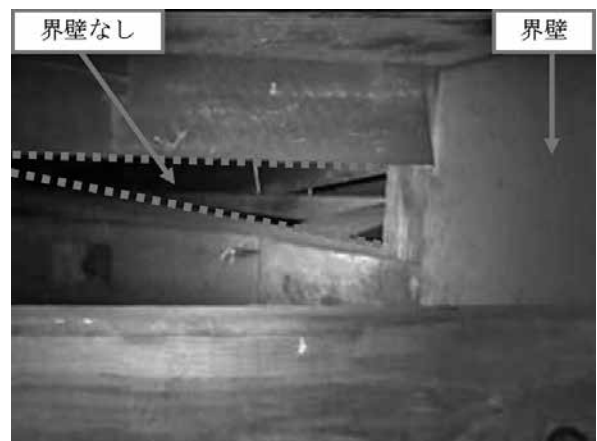
写真4 廊下上部小屋裏の状況
