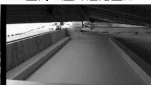
B-C室間の屋外通路上部
