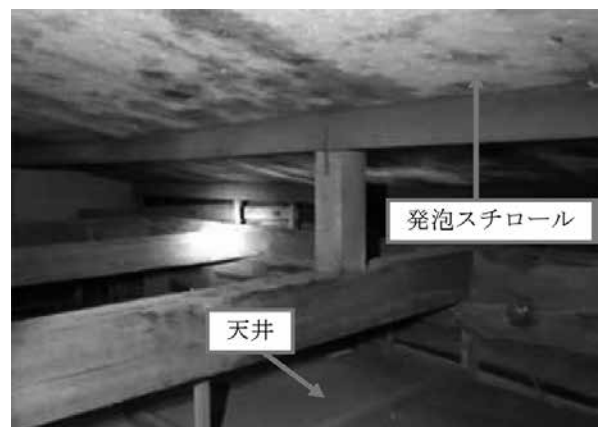
写真5 小屋裏及び屋根側断熱剤の状況
