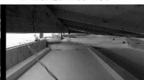
A-B室間の屋外通路上部
