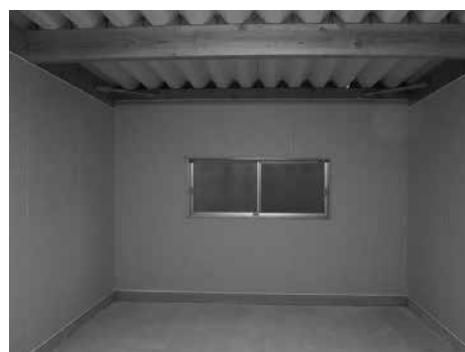
写真4 厚生労働省国立療養所長島愛生園車庫
