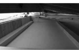
B-C室間の屋外通路上部
