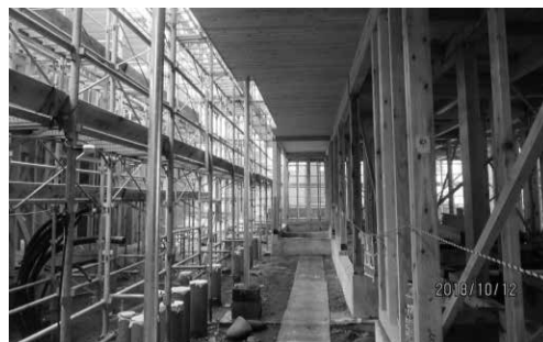
工事中の内部
