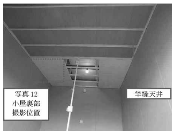
写真13 C室天井の状況
