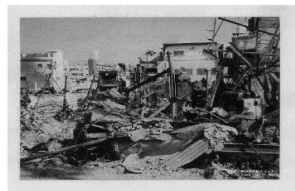
写真1 阪神・淡路大震災の被災状況
