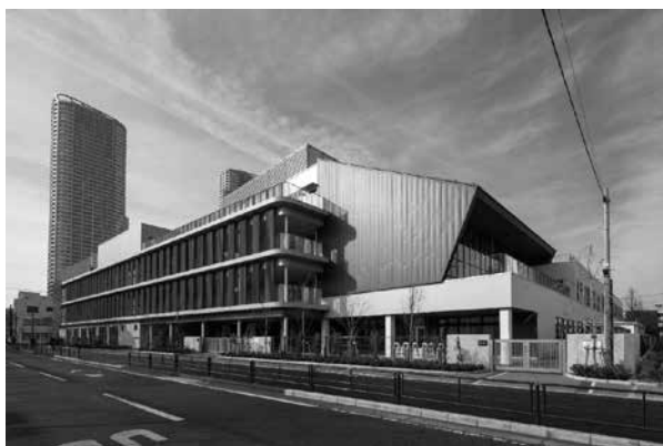
市内公共建築物の木質化事例 川崎市立小杉小学校
