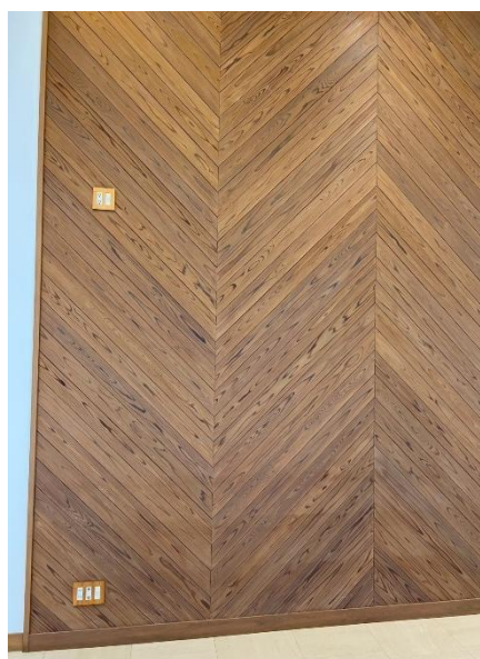
写真 37 屋内壁面の様子 1
