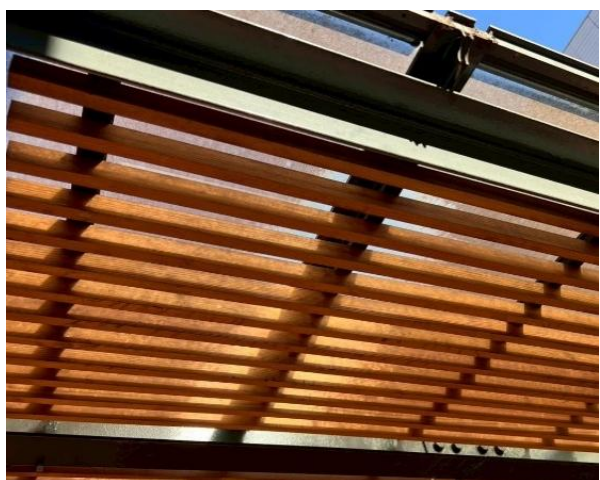
写真 2 ルーバー使用箇所
