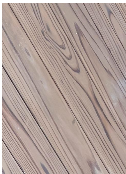
写真 40 屋内壁面の様子 3
