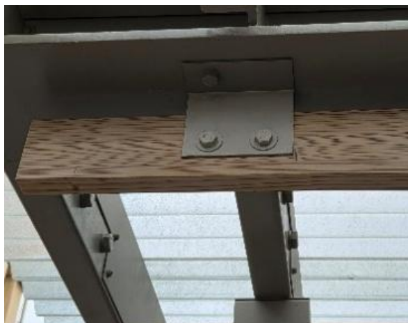
写真 27 軒天使用箇所 1 先端部
