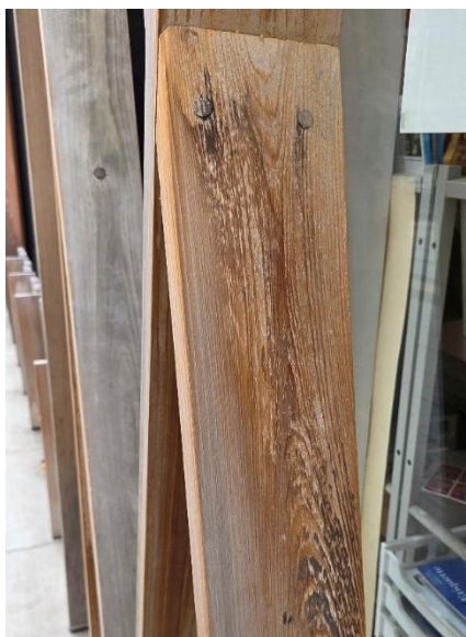
写真 12 屋外壁面使用箇所 2 側面
