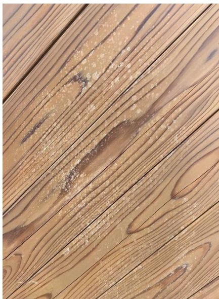
写真 41 屋内壁面の様子 4
