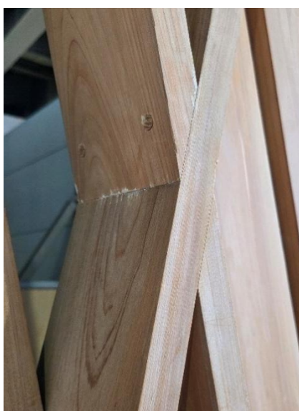
写真 20 半屋外壁面使用箇所 3 側面
