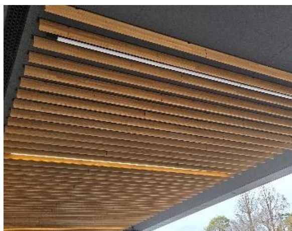
写真 35 ルーバー使用箇所 2
