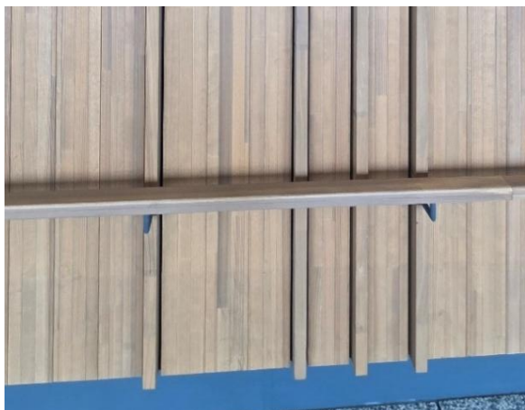
写真 32 壁面使用箇所 1 拡大
