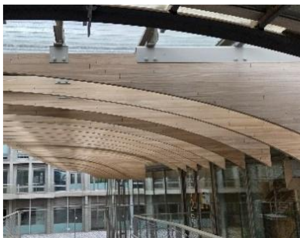
写真 24 軒天使用箇所 1
