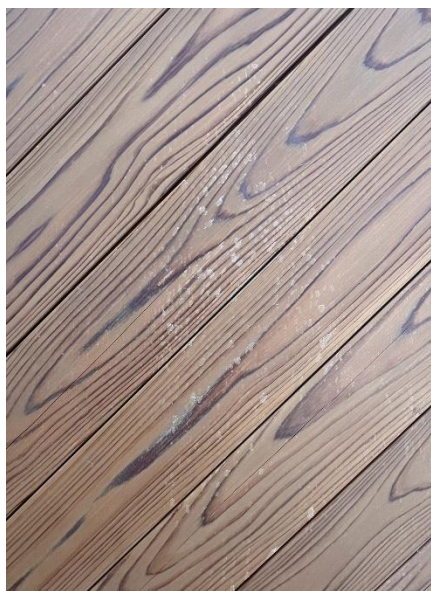
写真 42 屋内壁面の様子 5
