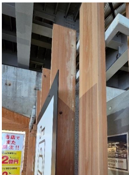
写真 16 半屋外壁面使用箇所 2 拡大
