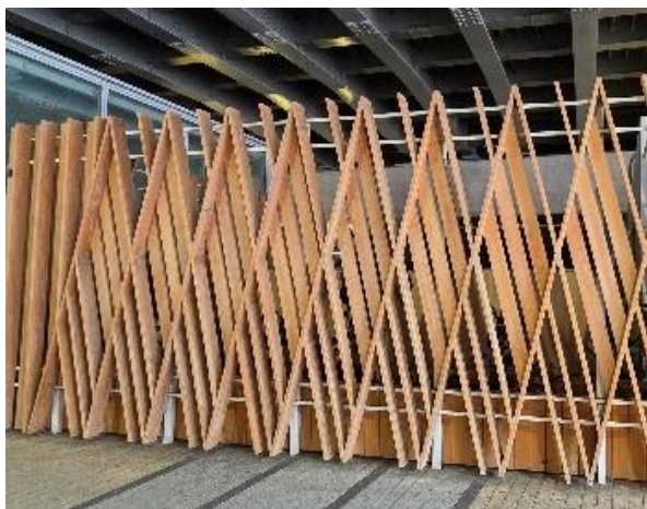
写真 18 半屋外壁面使用箇所 3 外観
